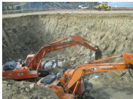
Escavação na zona do fosso de descarga
