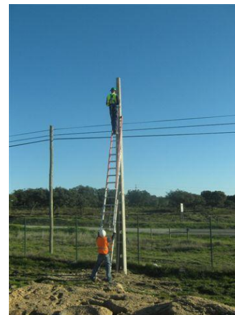
Colocação do cabo para o ramal elétrico da Obra
