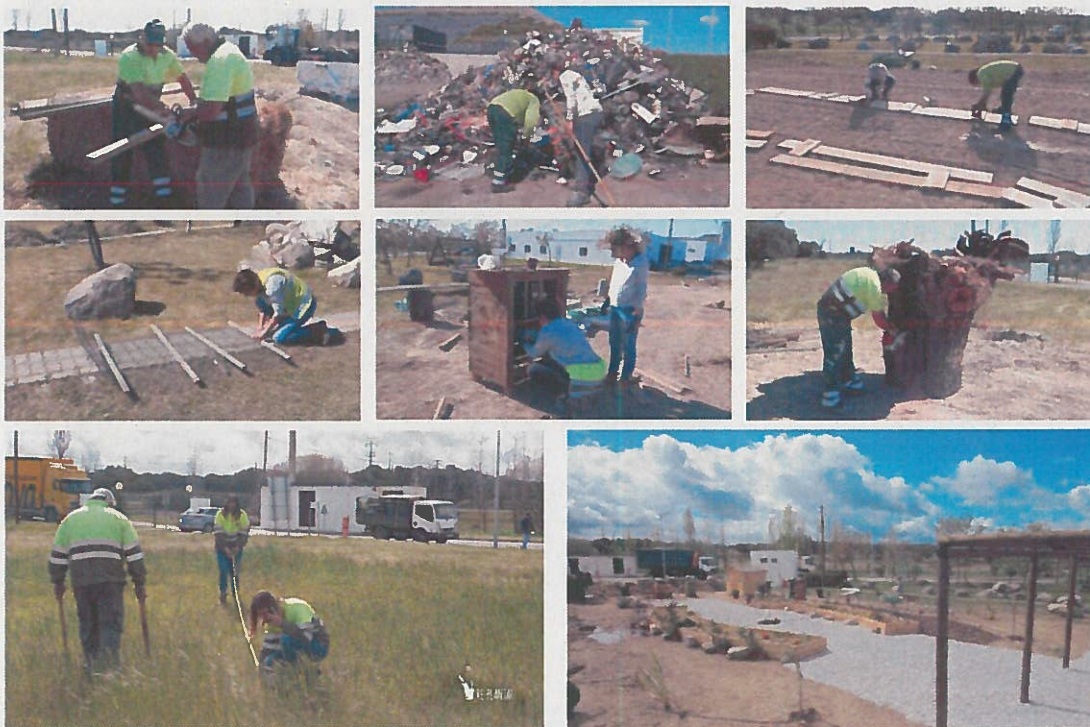
Imagens 2 a 9 – Construção Centro Re-Planta!
